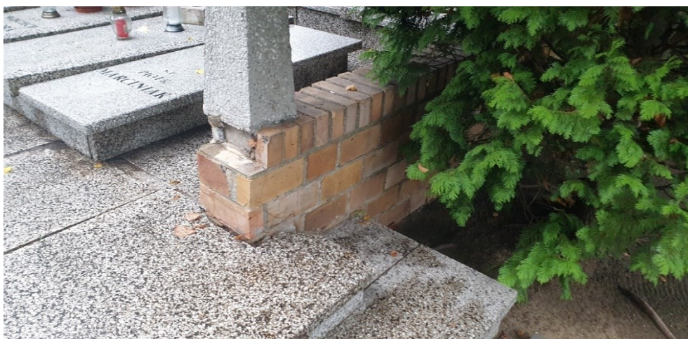
Niskiej jakości materiały wykończeniowe – pękające cegły i ubytki.
